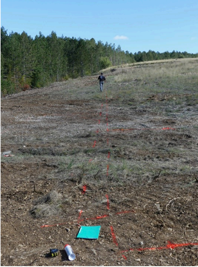
Positionnement tranchée interne (avec quelques rattrapages d'erreurs de parallaxe !!)
