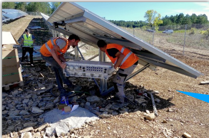
14h : pose du premier onduleur HUAWEI 33 kVA (poids ≈ 60 kg)
