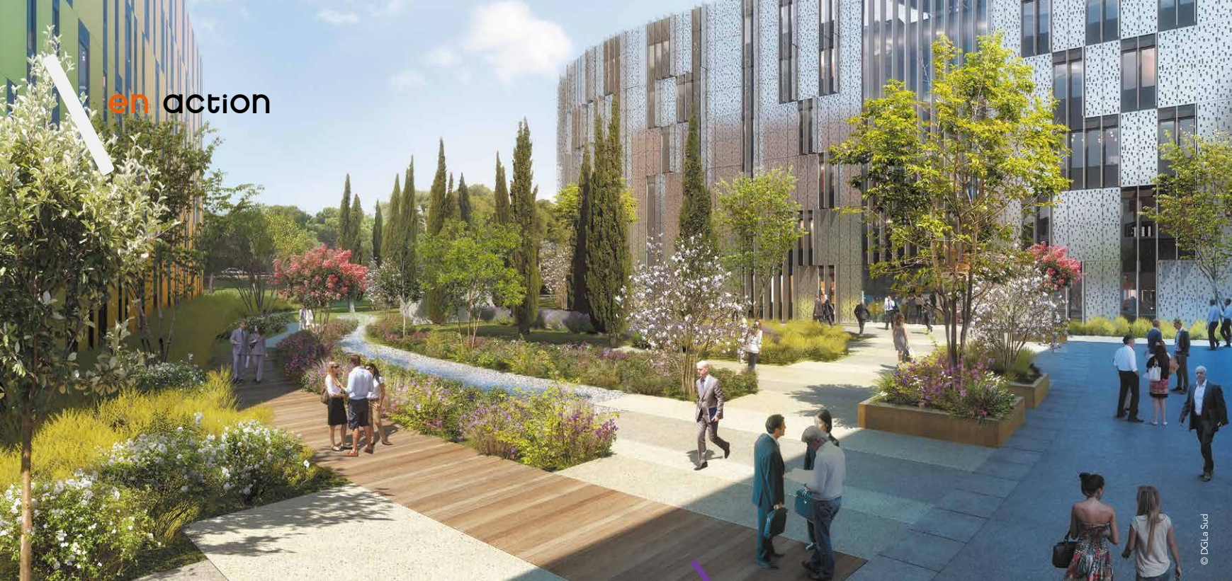
L'Asset Center, un programme de 33 000 m 2 répartis sur 7 bâtiments, véritable vitrine économique, a été retenu par la Métropole pour sa qualité architecturale et environnementale.
